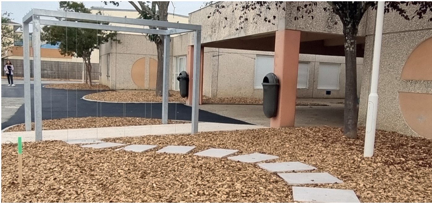
Parvis après les travaux en attente des plantations et du mobilier urbain
